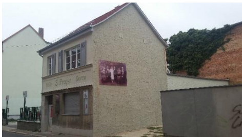
Das Prager-Haus nach der Renovierung, 2018, User: BrThomas (CC BY-SA 4.0)
